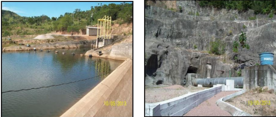
Figura 13. Fotografias da tomada d'água e do conduto forçado. 11
