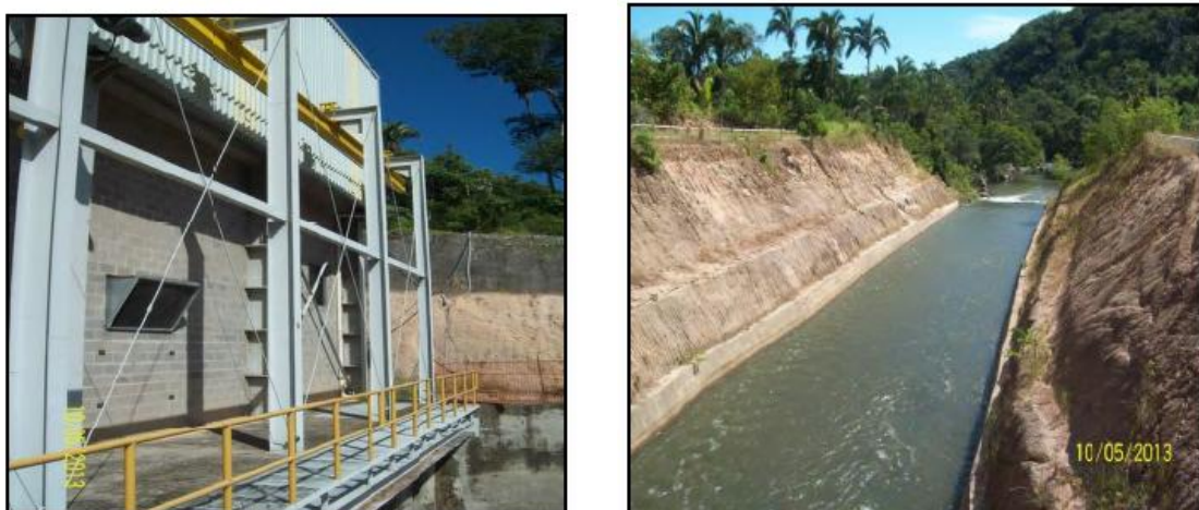
Figura 14. Fotografias da casa de força e do canal de fuga. 11
