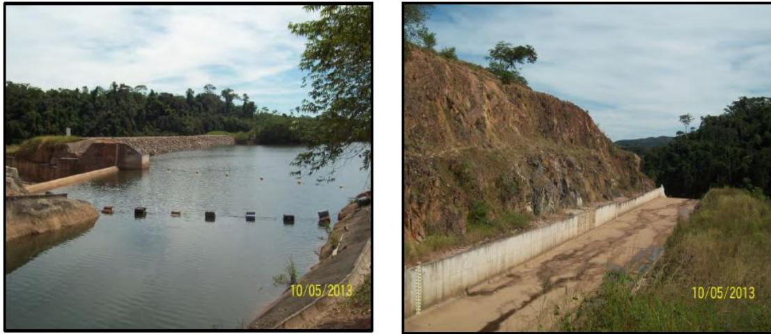
Figura 11. Fotografias do vertedouro e canal de restituição. 11
