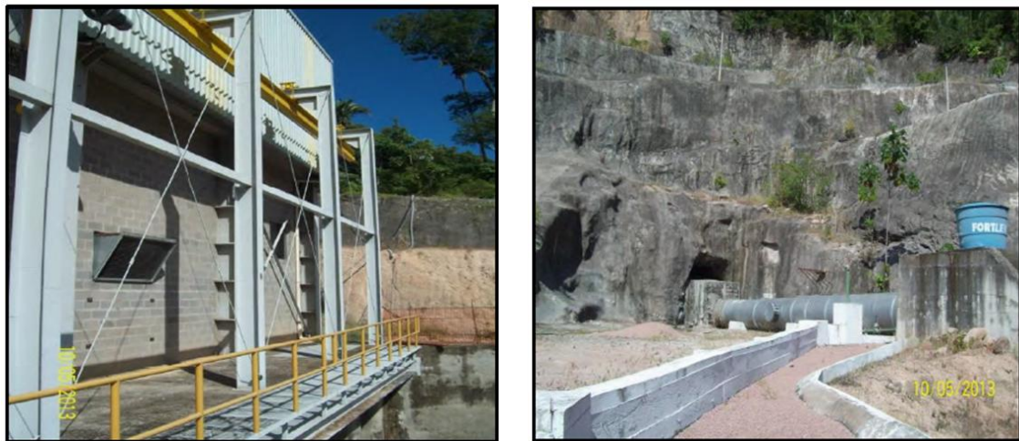
Figura 5. Fotografias da casa de força e condutos forçados. 11
